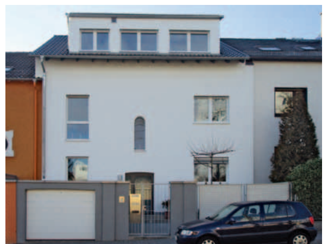
Reihenhaus nach der Modernisierung u. a. mit 30 \text{ cm} WDVS
