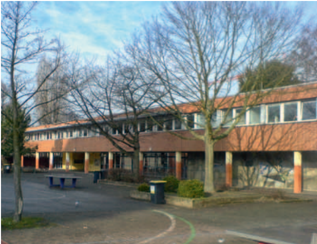
Gebäude vor der Modernisierung
