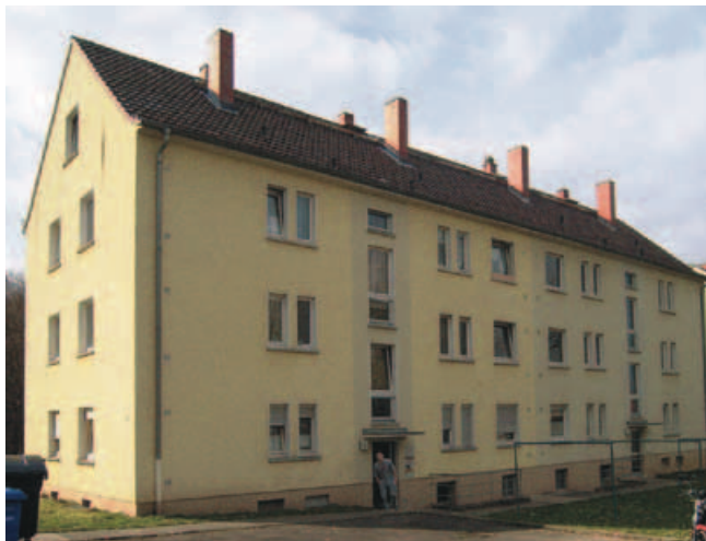
Mehrfamilienhaus in Gießen vor der Modernisierung
