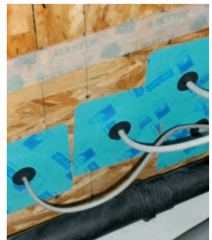
Luftdichte Durchführung von Elektrokabeln
