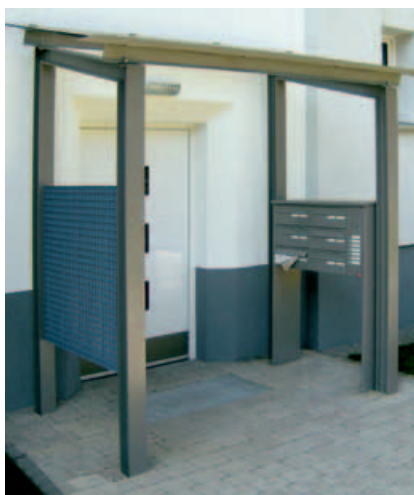
Nachher: Vermeidung der Wärmebrücke
