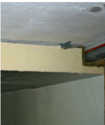
Kellerdeckendämmung mit Einbeziehung von Rohrleitungen
