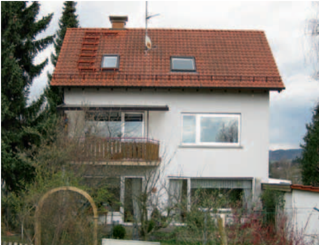
Gebäude vor der Modernisierung
