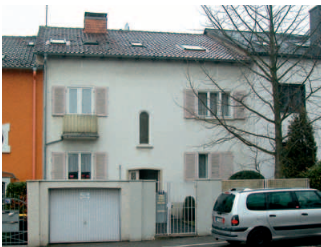
Reihenhaus in Frankfurt vor der Modernisierung
