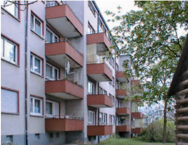
Gebäude vor der Modernisierung
