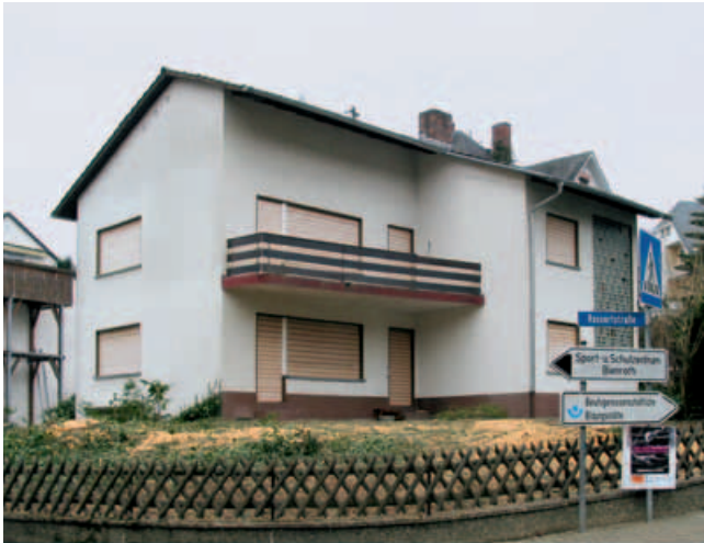
Gebäude vor der Modernisierung
