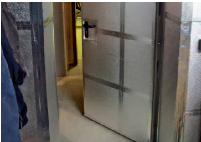
Wärmegeämmte Innenwände zum beheizten Kellerbereich
