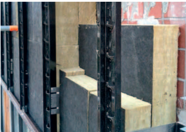
Unterkonstruktion der Vorhangfassade mit Wärmedämmung
