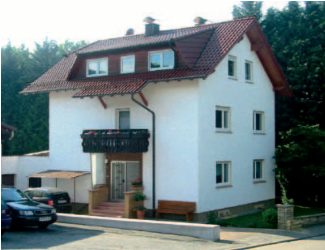
Gebäude vor der Modernisierung
