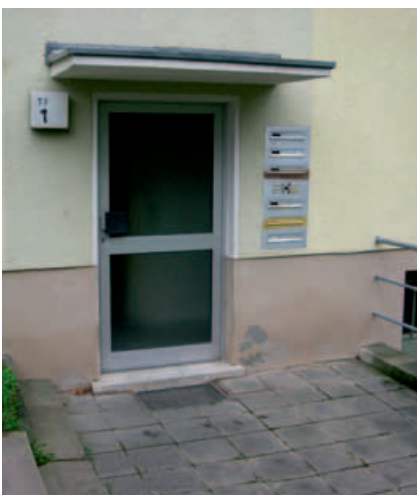
Vorher: auskragendes Vordach
