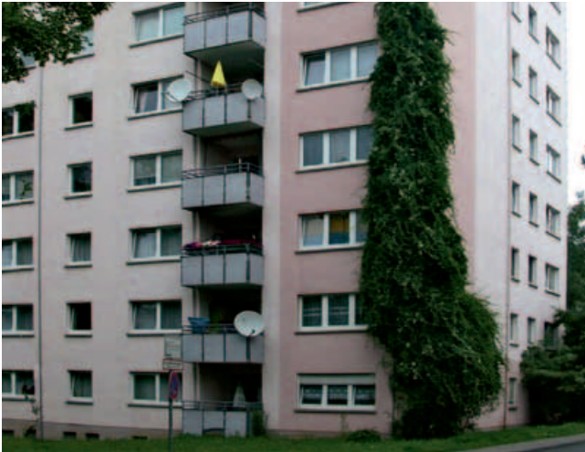
Gebäude vor der Modernisierung
