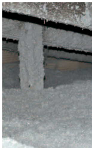
und nach der Einblas-Dämmung
