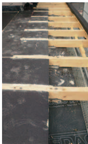
Wärmedämmung des Flachdachs
