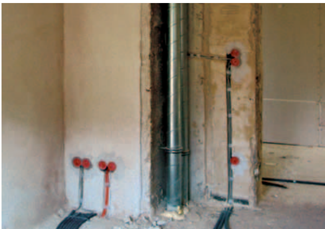
Lüftungskanal neben einem Kaminzug (vor Verkleidung)
