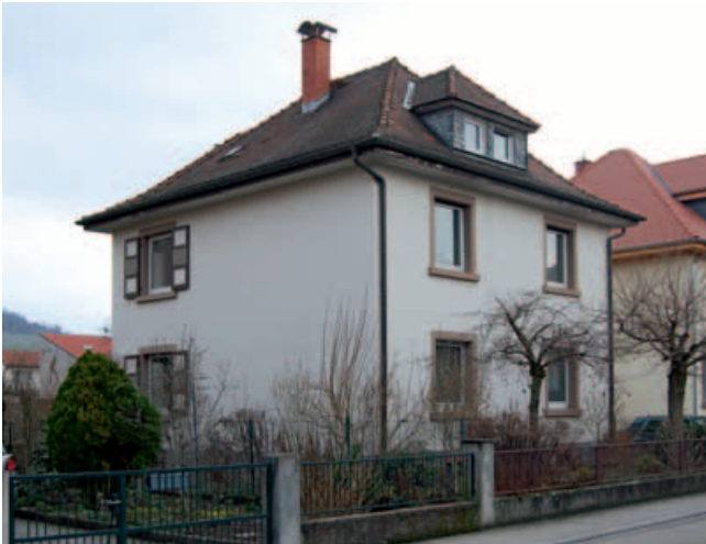
Gebäude vor der Modernisierung
