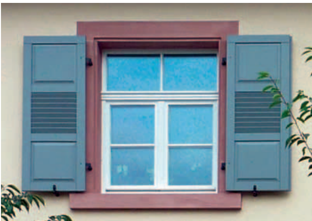
Fenster nach der Modernisierung
