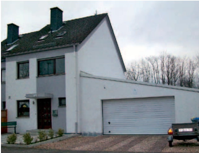
Gebäude vor der Modernisierung
