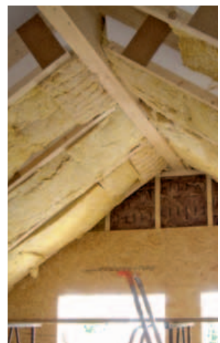
Zwischensparrendämmung des Schrägdachs
