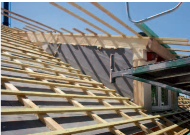
Dämmung der Dachgaube
