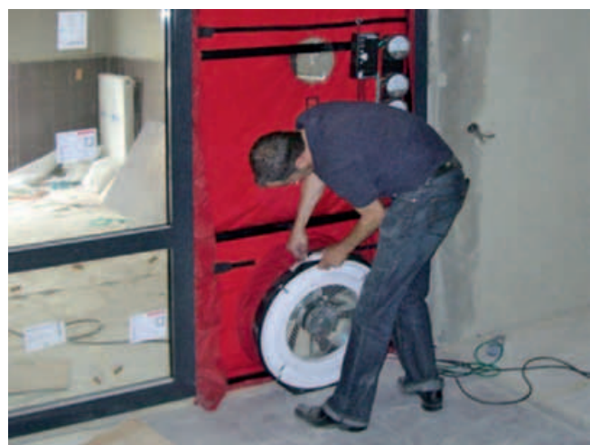
Vorbereitung einer Blower-Door-Messung
