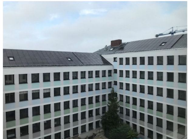
Gedämmte Innenhoffassaden und neues Farbkonzept, Dachflächen mit 255 kWp Photovoltaikanlage
