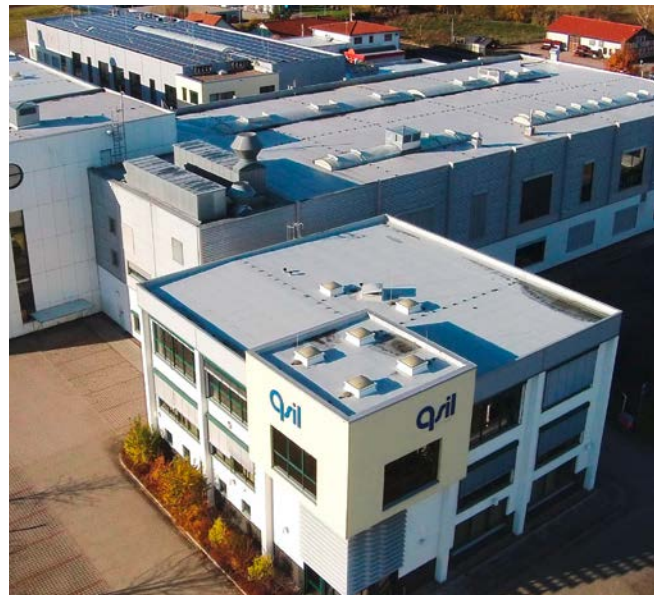
Das Firmengelände der Qsil GmbH in Langwiesen
