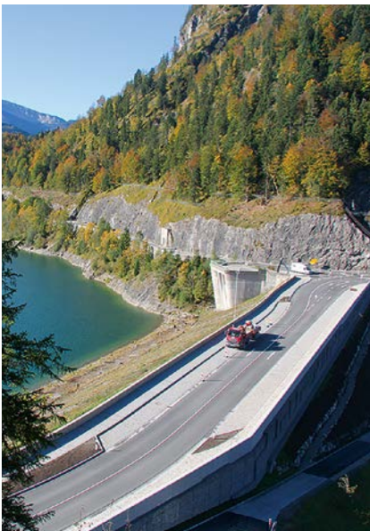
Damm des Sylvensteinspeichers nach Abschluss der Bauarbeiten
