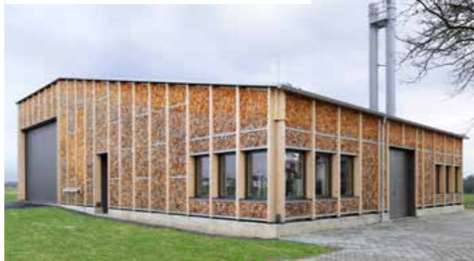
Heizzentrale Schulgelände, Babenhausen Eßmann, Gürtner, Nieper Architekten GbR, Darmstadt [P]
