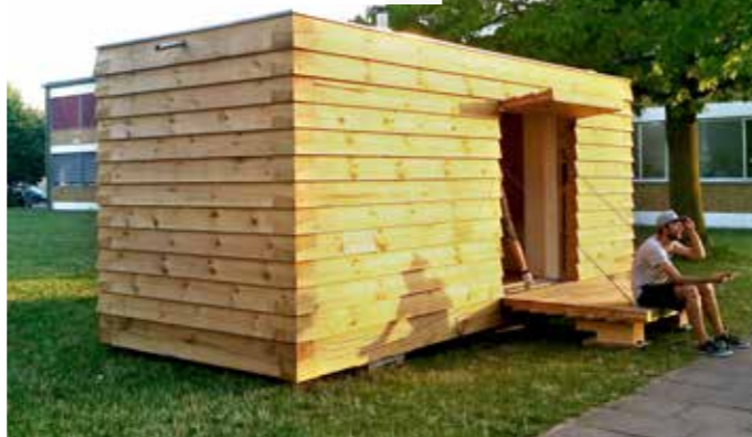
Wohncontainer Forst-Mobil, Darmstadt Hochschule Darmstadt, FB Architektur [P]
