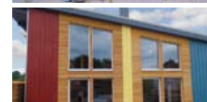
Anbau SHT Ausstellungsraum Lauterbach Bien-Holz GmbH Lauterbach
