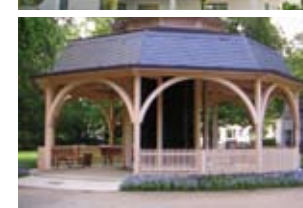
Neubau Gradier-Pavillon Bad Salzschlirf Kur- und Tourismus GmbH
