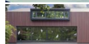
Sanierung Vogelschutzwarte Frankfurt Hessen Forst
