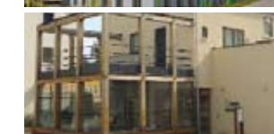
Umbau einer Scheune Herborn Architekturbüro Karim El Ansari
