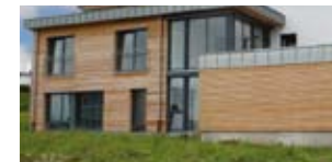
Neubau Energiesparhaus Eichenzell Herrmann Massivholzhaus GmbH
