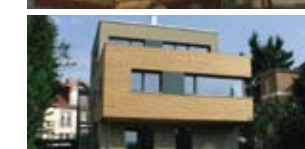
Aufstockung Passivhausstandard Bad Vilbel D.Robinski, P. Hufer
