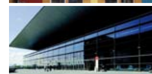
Messehalle und Portalhaus Messe Frankfurt Messe Frankfurt-Venue GmbH & Co. KG
